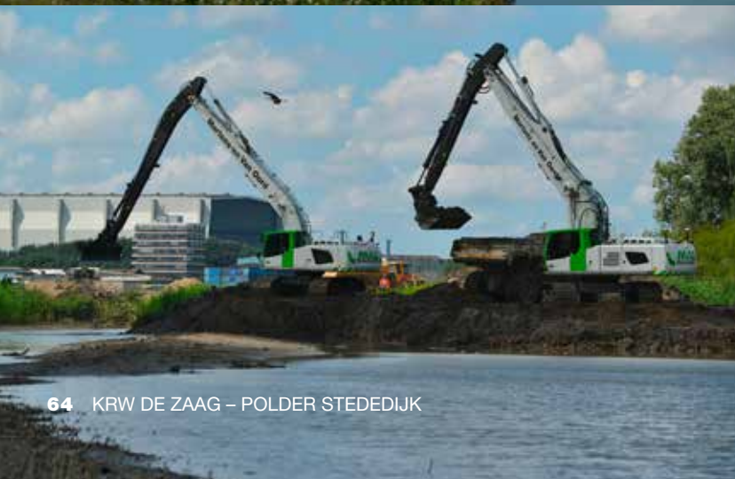
Aanleg van de brede kreek in polder Stedelijk
