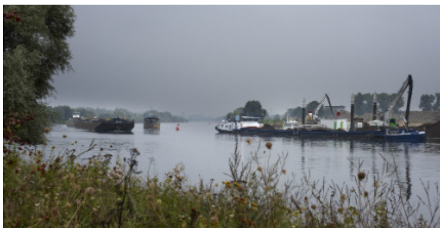
Figuur 1: Werkzaamheden bij bocht Steyl
