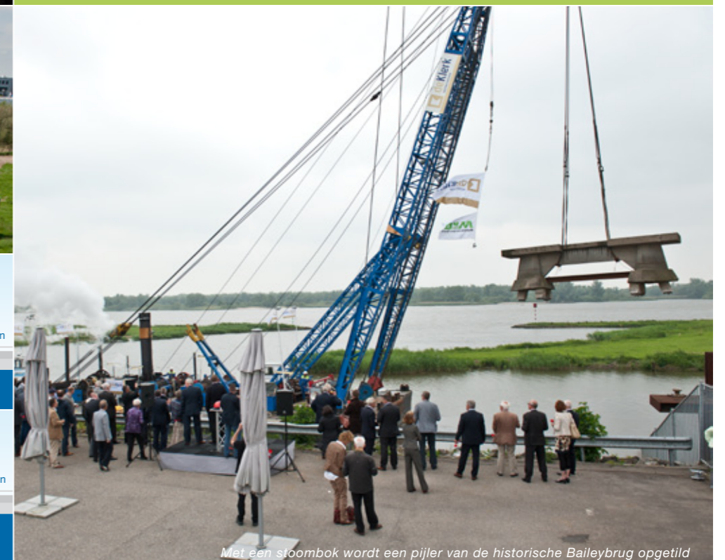
Met een stoombock wordt een pijler van de historische Baileybrug opgetild
