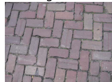
Gebakken klinker, kleur en type centrum Werkendam. Keiformaat. Legverband: elleboog
