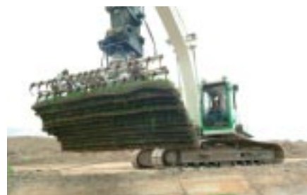
12. Op weg naar het talud
