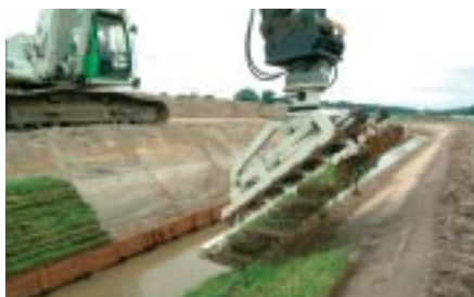
13. Plaatsen van de graszoden op het ene talud...
