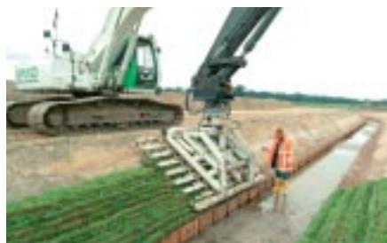
14. ... en op het andere talud
