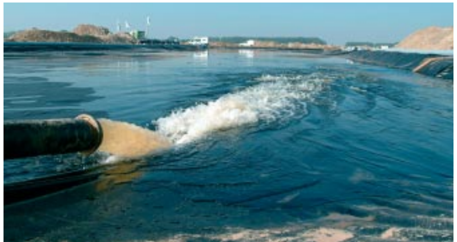
Door middel van water wordt de folie afgezonken
