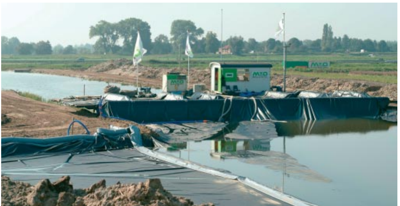
Door middel van water wordt de folie afgezonken
