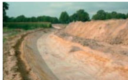
2. Taluds gereed voor betuinging en graszoden
