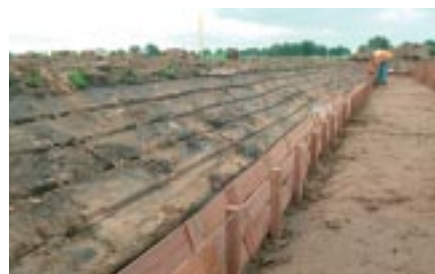
5. Aanbrengen van schotten
