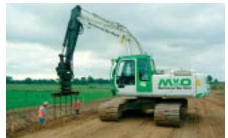
3. Prikbalk voorzien van een trilblok
