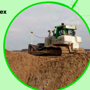
Verwerking van zand voor de aanleg van de bouwwegen in Dyhrssenmoor
