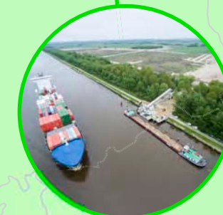
Lossen van zand in Dyhrssenmoor met een transportband
