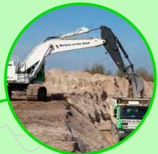
Ontgraven zand uit zanddepot in Beldorf
