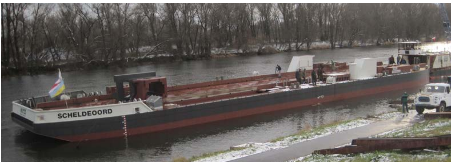
Splitsbak in aanbouw
