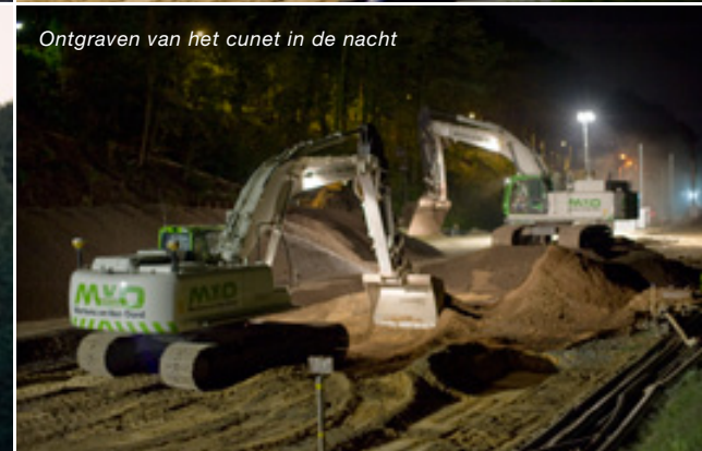
Afvoeren van vrijkomend materiaal naar zeefinstallatie
