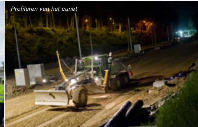
Ontgraven van het cunet in de nacht
