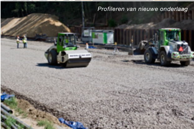
Verwerken van ballastmateriaal
