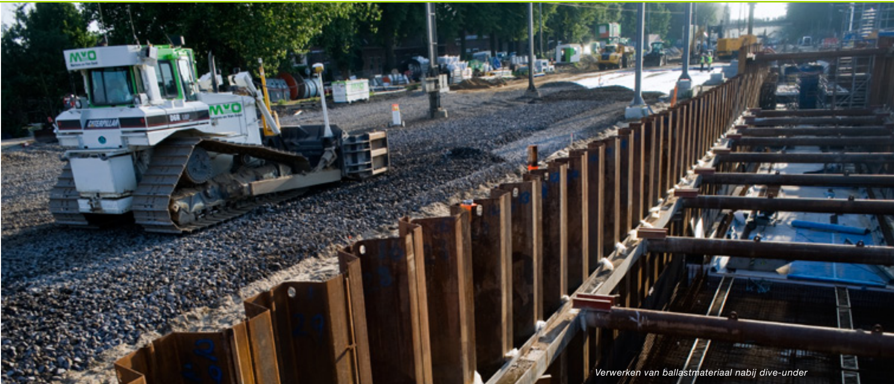
Profileren van nieuwe onderlaag
