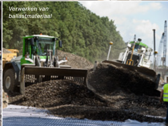
Profileren van nieuwe onderlaag
