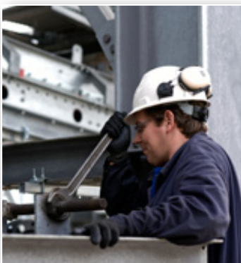
Arno van Exsel Monteur installatie
