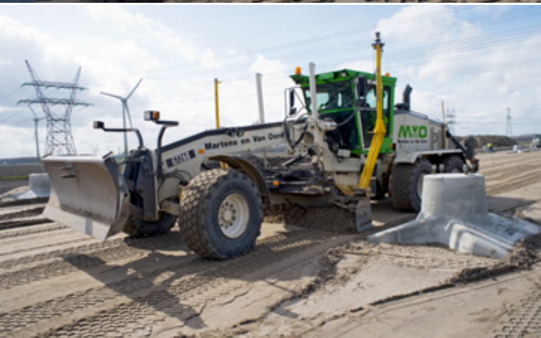
Plaatsen van fundaties voor de bovenleiding en het fijnprofielen van de zandbaan
