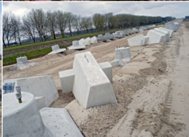
Plaatsen van fundaties voor de bovenleiding en het fijnprofielen van de zandbaan
