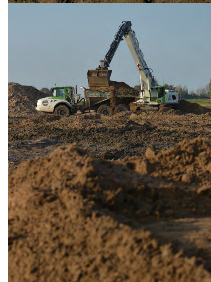
De bulldozer verwerkt grond in de Diepe Plas
